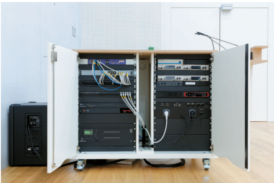
Medientechnik in einem rollbaren Möbel am Dozentenplatz eines Hörsaals
