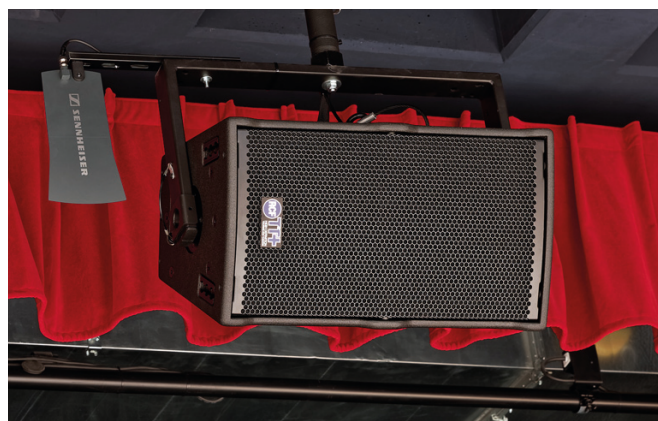
RCF-Lautsprecher mit integrierten Endstufenmodulen
