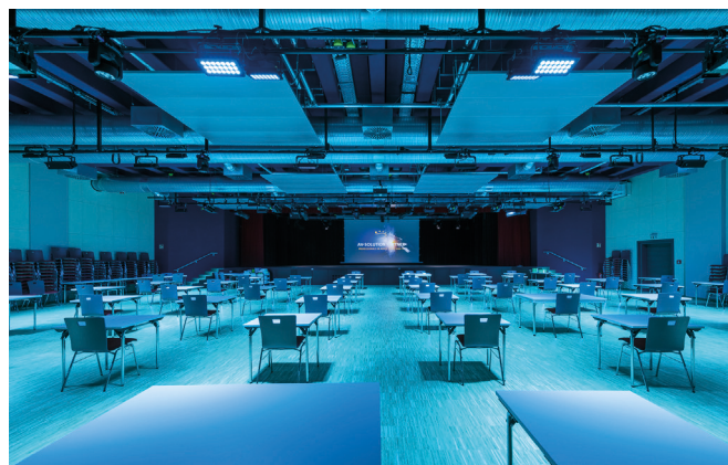
Eine zentrale Lichtsteuerung sorgt für einfachste Bedienung
